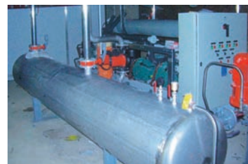
Cuve d'eau Glycolée et groupe frigorifique Glycol water tank and refrigeration unit
